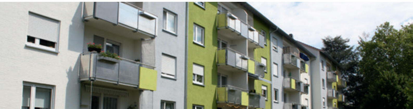
Neue Gestaltung der Fassaden in den Wohnanlagen in der Alex-Müller-Straße.
