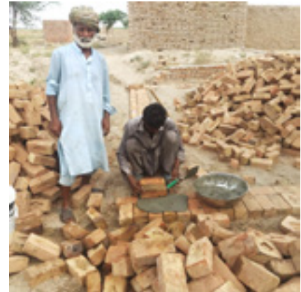
Arbeiten am Fundament des Hauses für älteren Herren (links) und seine Familie.
