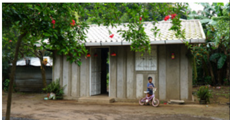
Die neuen Häuser in Mirazul del Llano sind Erdbeben resistent gebaut. Nicaragua_Foto
